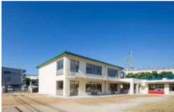
増築園舎外観
